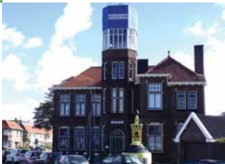
1916 Gemeentelijke Visserijschool Havenkade 55, IJmuiden Gemeentelijk monument In 1950 uitgebreid door J.P. Koopen (lokalen), in 1961 en 1965 door H.J. Peters (kantine en verhoging toren) en in 1980 met een bankwerkerij door J.J. Jansen. Nu: Zee- en Havenmuseum "De Visserijschool"
