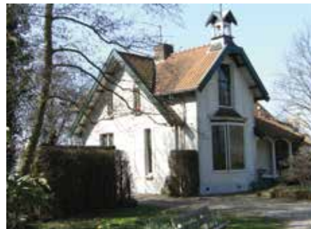
1906 Voormalige doodgraverwoning Begraafplaats De Biezen, Kwekerslaan 12, Santpoort Provinciaal monument
